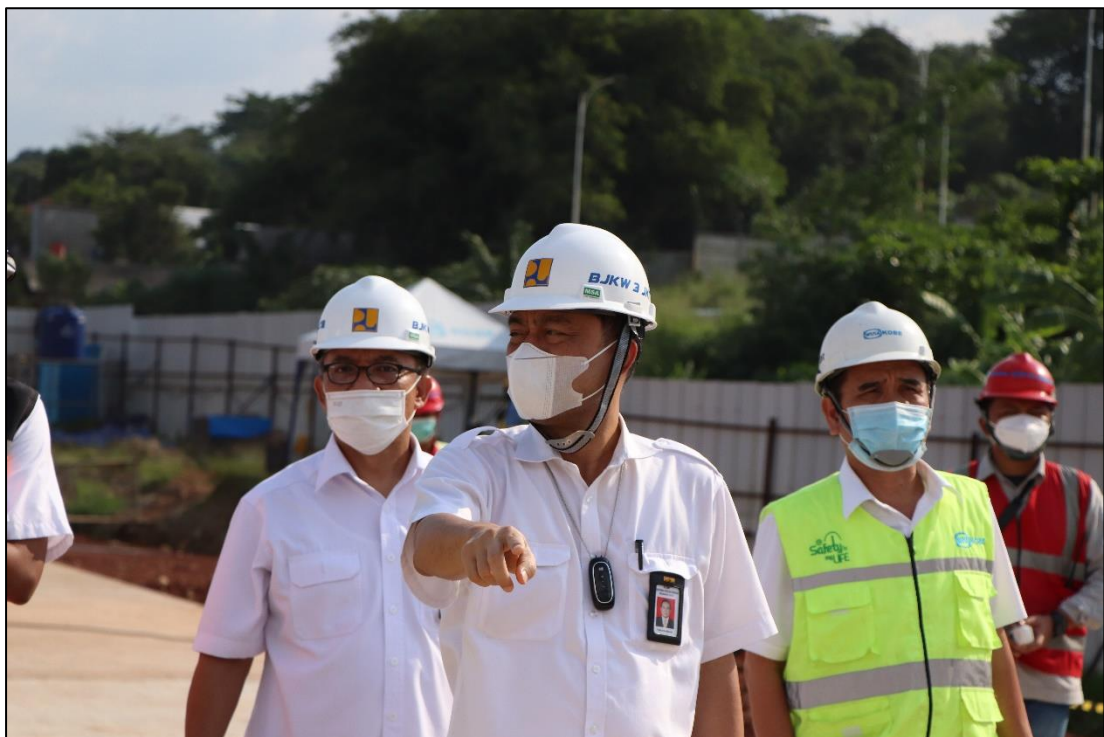
Gambar 53 Peninjauan Pembangunan Balai Pelatihan SDM Konstruksi Layang di Citeureup
