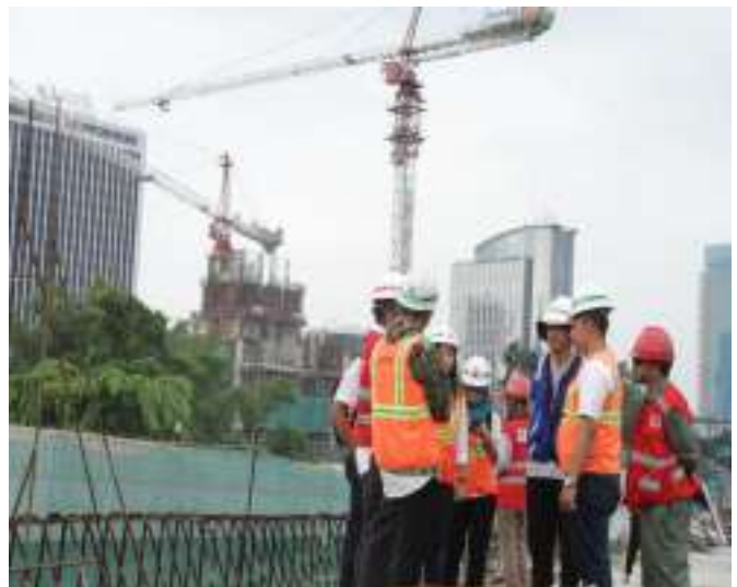
Peninjauan Pembangunan Proyek Jalan Layang
