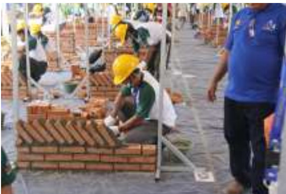
Gambar 13. Lomba Pekerja Konstruksi Tingkat Nasional
