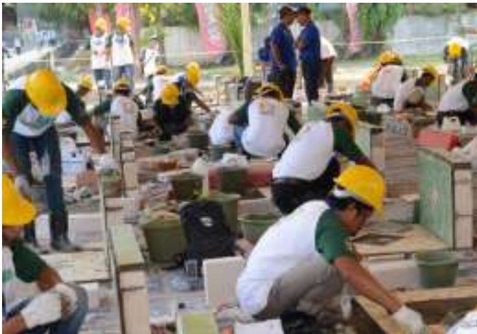
Lomba Pemasangan Ubin pada Kegiatan Konstruksi Indonesia 2017
