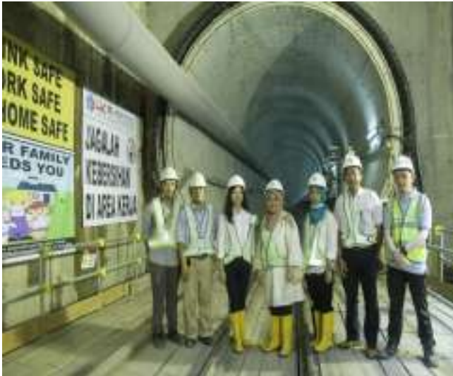
Peninjauan Pembangunan Proyek MRT
