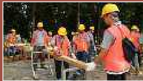
Pembinaan Tenaga Konstruksi Terampil Bidang Kayu dengan Mobile Training Unit
