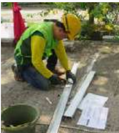
Gambar 3. Aplikator Baja Ringan Memotong Material Rangka Atap Sesuai Dengan Detail Gambar Kerja
