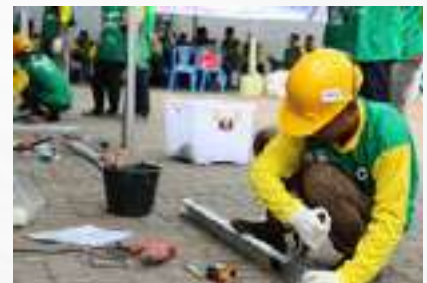
Gambar 5. Pemasangan Rangka Atap Sesuai Gambar Kerja
