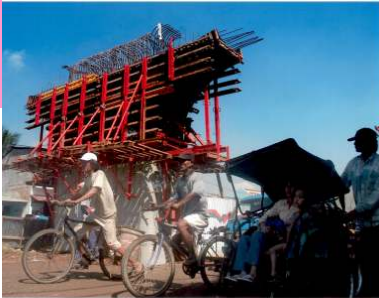
Pekerjaan Konstruksi Jalan Layang
