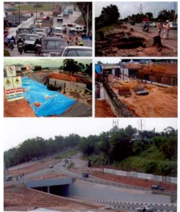
Pekerjaan Konstruksi Under Pass
