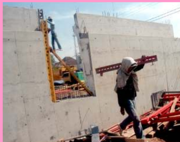
Pekerjaan Konstruksi Jalan Layang
