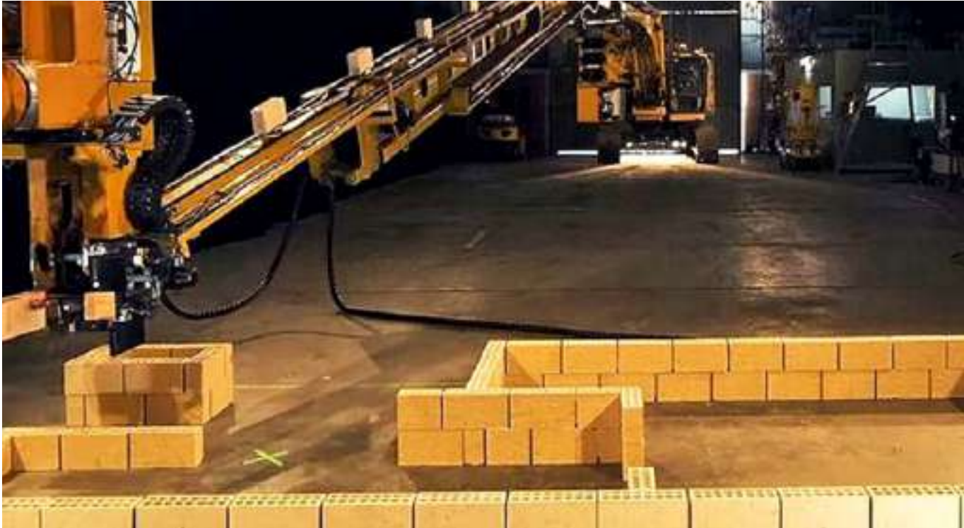
Gambar 10.4.9. Robot Pemasang Bata Hadrian X
