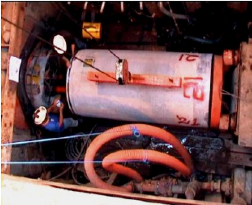
Gambar 17. Pemasangan Pipa yang akan dijacking
