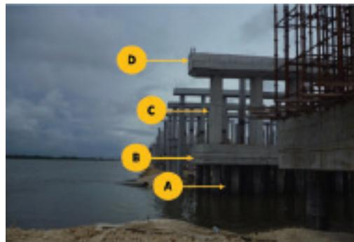
Secara umum, tipe struktur yang digunakan pada jalan tol ini adalah *elevated road* dengan struktur *pile on slab* pada lokasi – lokasi yang memiliki elevasi normal, dan beberapa jembatan girder sederhana pada lokasi yang elevasinya dituntut untuk lebih tinggi, seperti pada lokasi yang melewati hutan mangrove, alur nelayan, dan pada lokasi *interchange*.
