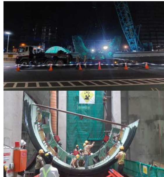
Gambar 4. Loading TBM di Proyek CP201
