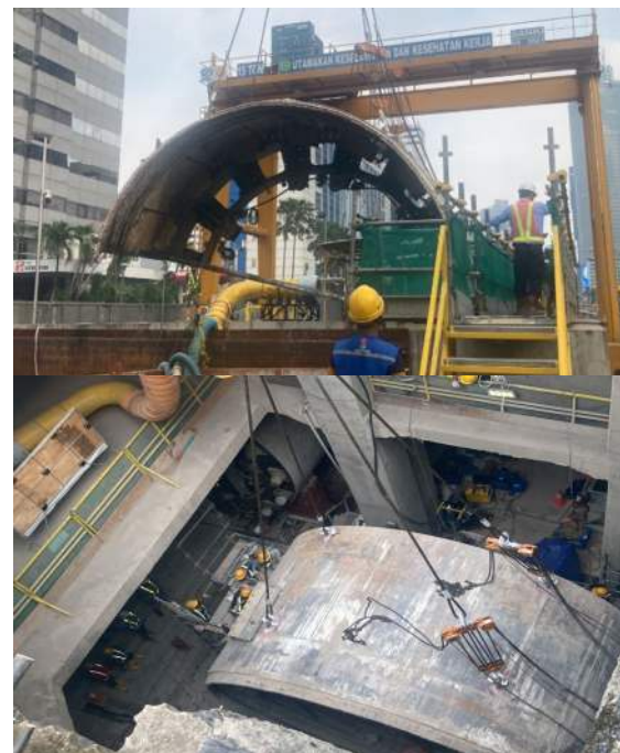
Gambar 5. Unloading TBM di Proyek CP201
