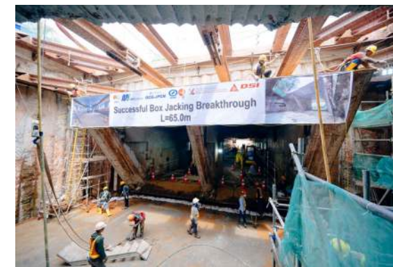
Gambar 8. Pekerja sedang membersihkan area entrance 1 setelah penyelesaian pekerjaan. Foto oleh PT MRT Jakarta (Perseroda)/Dio.
