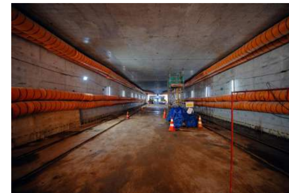
Gambar 9. Area entrance 1 Stasiun Monas. Foto oleh PT MRT Jakarta (Perseroda)/Dio.
