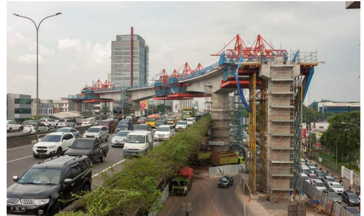
Gambar 1. Pembangunan Fase 1 Lin Utara Selatan
