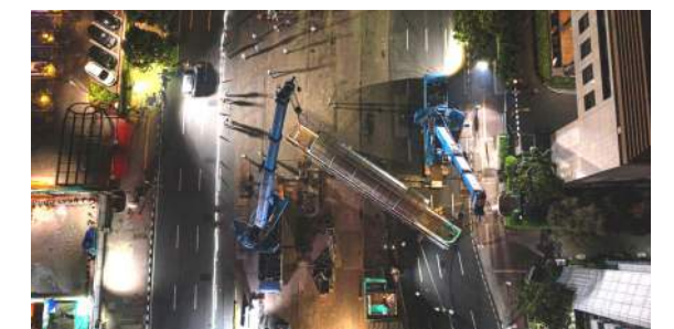
Gambar 10. Tim konstruksi sedang mengangkat badan JPO Thamrin10 sebagai bagian dari pembangunan stasiun Thamrin. Foto oleh PT MRT Jakarta (Perseroda)/Faisal.
