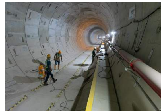
Gambar 14. Pekerja sedang berada di terowongan penghubung Stasiun Thamrin dan Monas. Foto oleh PT MRT Jakarta (Perseroda) /Irwan Citrajaya.
