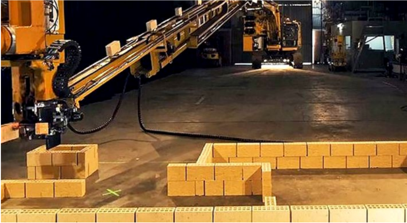
Gambar 10.4.9. Robot Pemasang Bata Hadrian X
