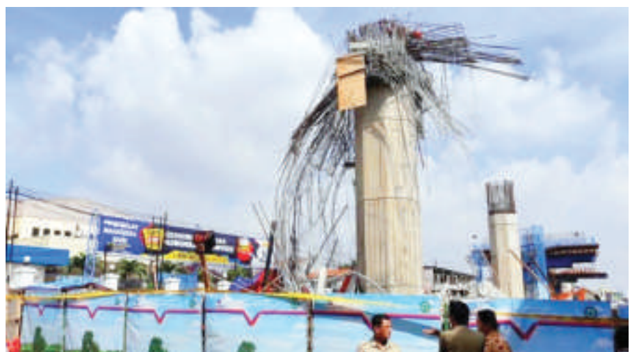
Jalan Tol Bekasi Cawang Kampung Melayu (Becakayu) yang mengalami kejadian ambruknya bekisting pier head
