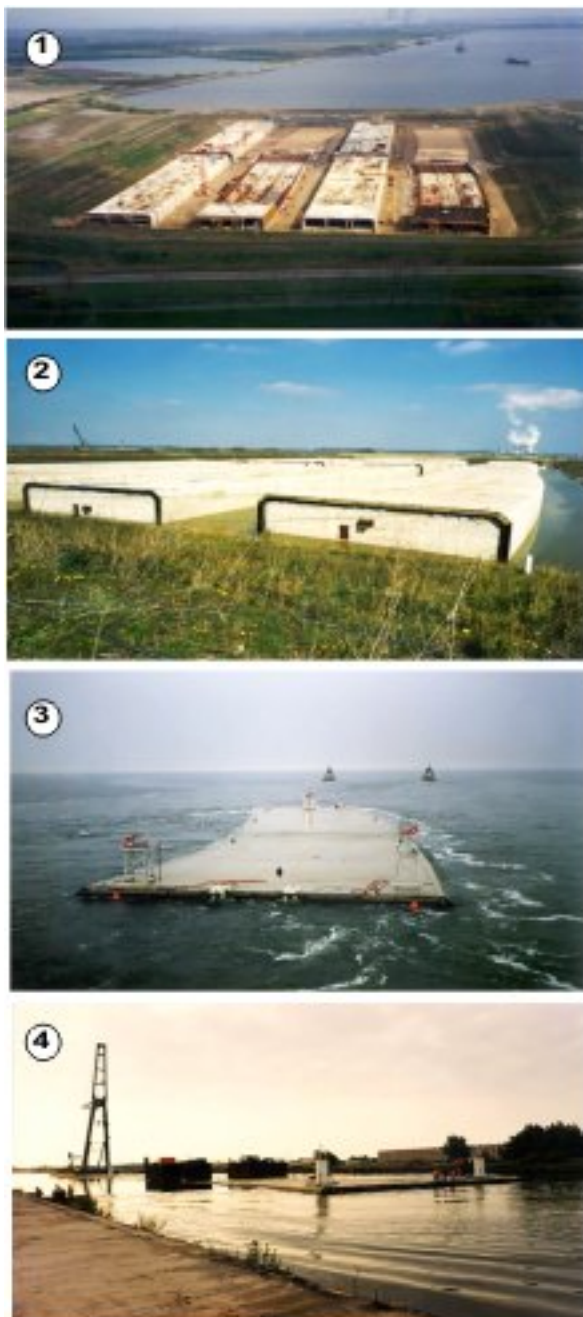
Gambar 3. Fase-fase dalam konstruksi immersed tunnel
