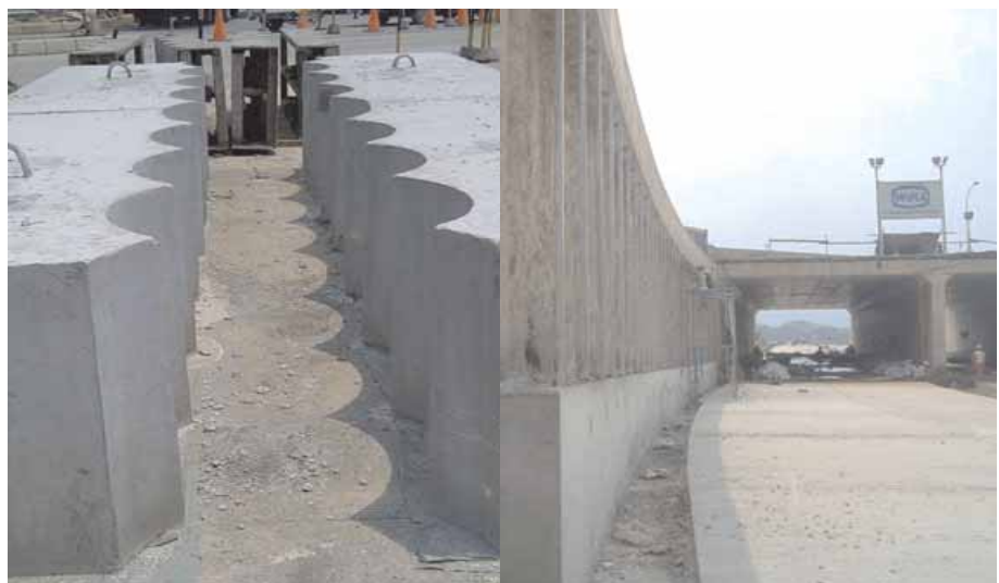
Kategori Metode Konstruksi : Metode Konstruksi Guide Wall Precast untuk Pelaksanaan Secant Pile Pengaju Karya : PT Wijaya Karya (Persero) Tbk.
